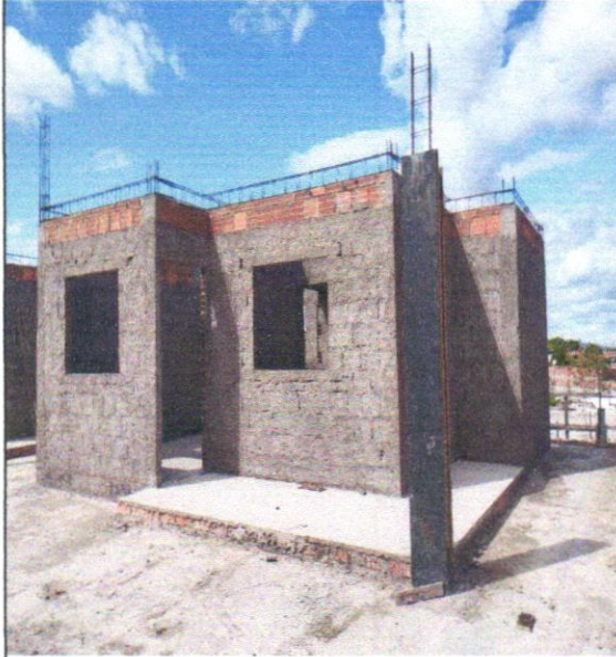
MONTAGEM E CONCRETAGEM DE PILARES
