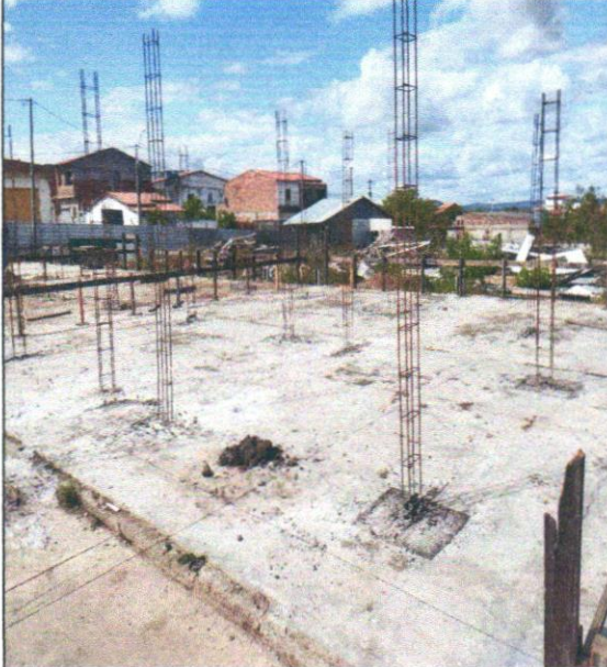
ARMAÇÃO DE SAPATA, VIGA BALDRAME E PILAR
