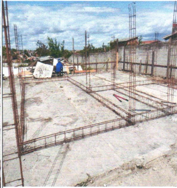
ARMAÇÃO DE SAPATA, VIGA BALDRAME E PILAR
