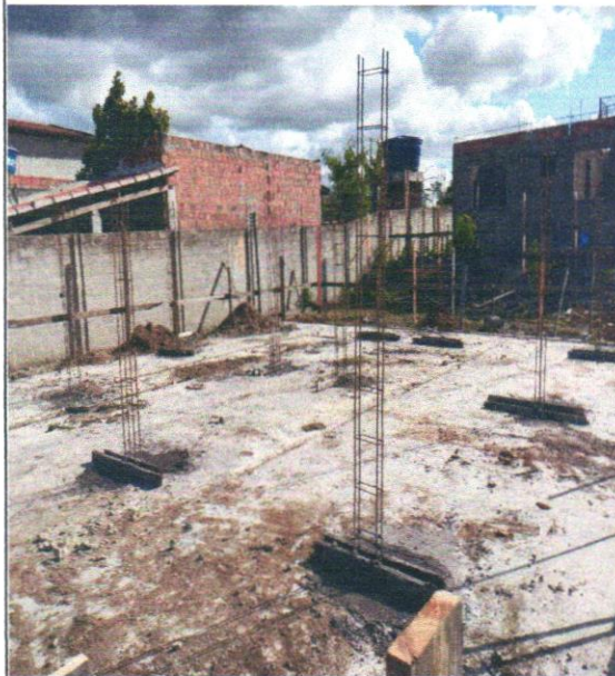
ARMAÇÃO DE SAPATA, VIGA BALDRAME E PILAR
