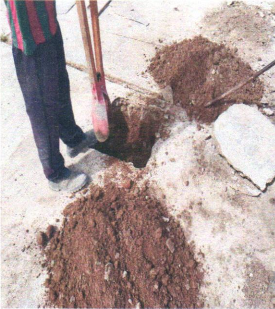
ESCAVAÇÃO MANUAL PARA SAPATA ISOLADA
