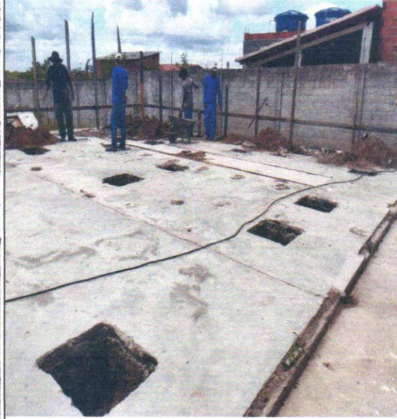
ESCAVAÇÃO MANUAL PARA SAPATA ISOLADA
